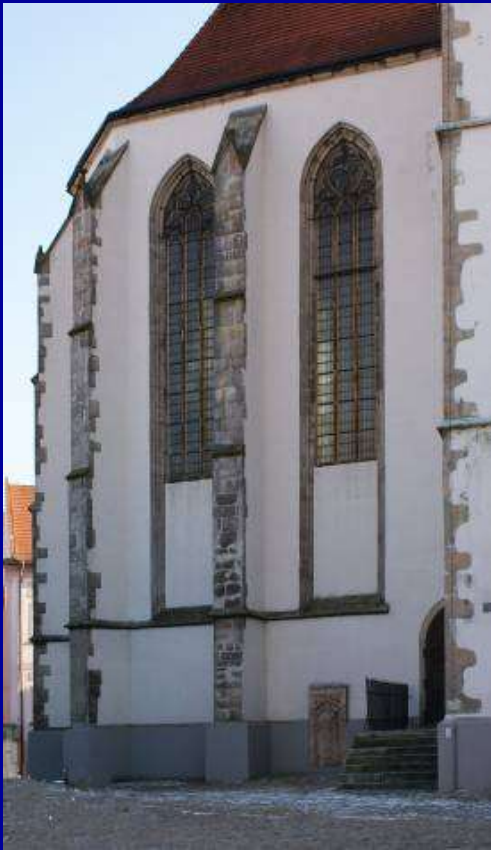
Vnější opěrný systém - pilíře External support system - Pillars
