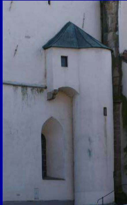
Schodiště na věž zabudované zvenku do skeletu budovy
